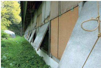
鶏舎の窓を少しずつ調整し、換気して鶏にとって心地の良い状態を作ります
