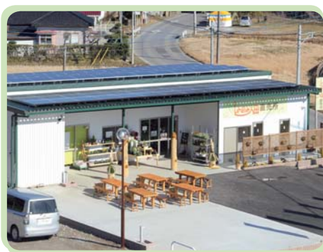
直売所「しんのみ畑」の屋根に設置された太陽光発電パネルで発電された電気が届けられます
